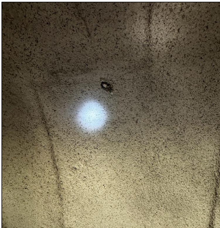
Foto 4. Pel 48, v. side: mindre skade på hvelvet.
