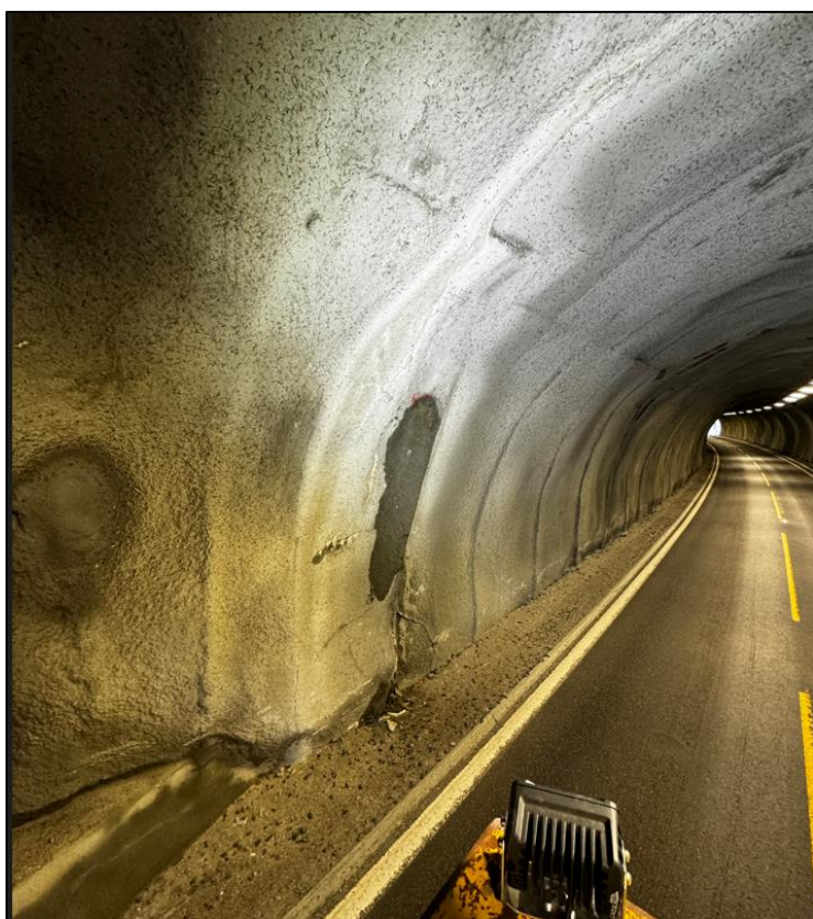
Foto 5. Eksempel på fukt i brannsikret PE.
