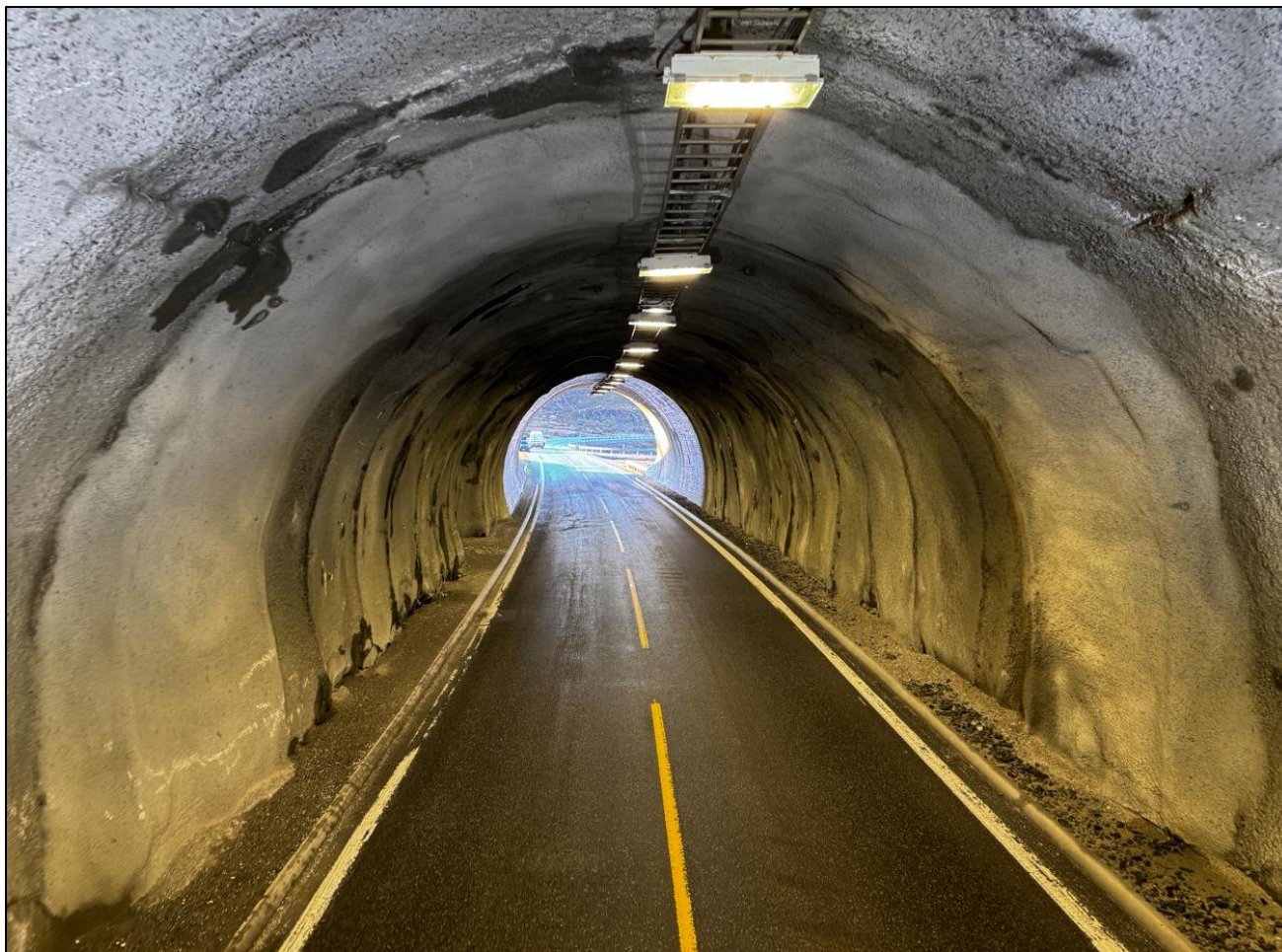
Foto 3. Generelle forhold i Sarnestunnelen. Tunnelen er dekket med brannsikret PE-skum.
